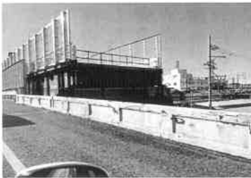
名鉄本線仮跨線橋
