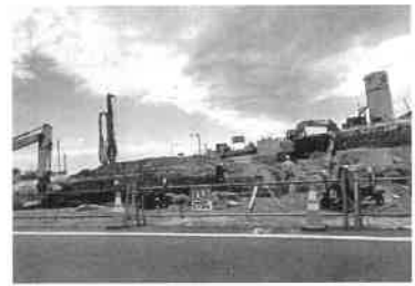
枇杷島橋堤防工事
