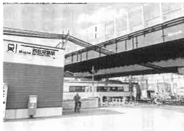
西枇杷島駅上部の仮跨線橋
