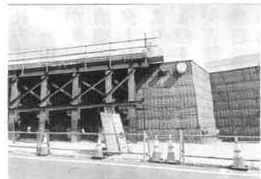
枇杷島橋との取付け部
