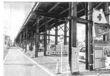
完成間近の仮跨線橋
