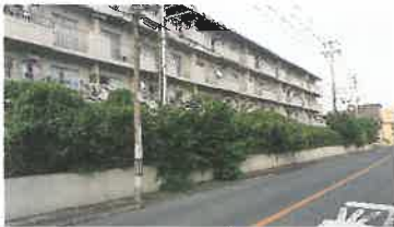
樹木が生い茂った県営住宅 「入居者高齢化等で剪定無理」 県が10月対応実施（阿賀南）
