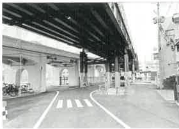
下から見る仮跨線橋
