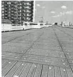
舗装前的高架橋部
