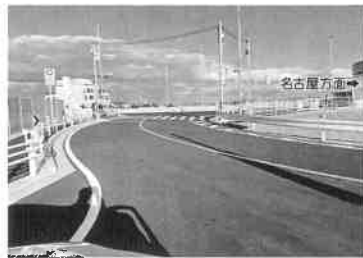
美濃路・庄内川堤防から 仮枇杷島橋に接続
