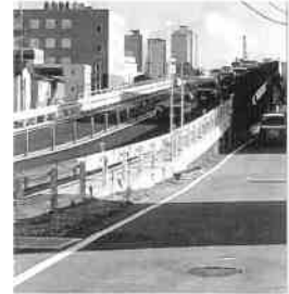
開通になった仮跨線橋
