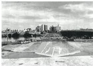
旧枇島橋の橋脚部分
