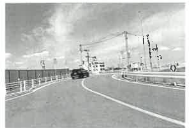
仮設枇島橋の交差点
