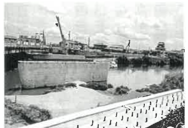
五條川に架かる清洲橋の工事
