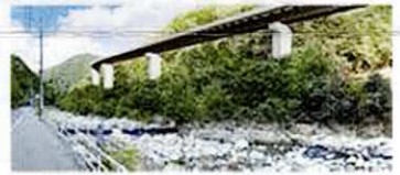
県道呉平谷線バイパス工事中
