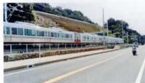
広島呉道路、JR 呉線復旧
