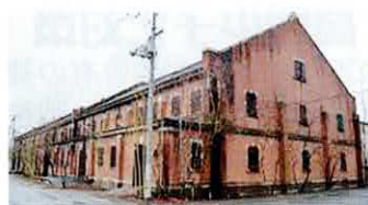
宇品の「旧陸軍被服支廠」4棟 原爆被災者の救護しになった
