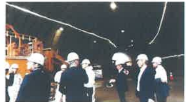
福山沼隈道路の建設 渋滞解消、利便性向上に
