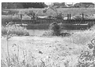
浚渫土砂の 運搬の陸揚げ
