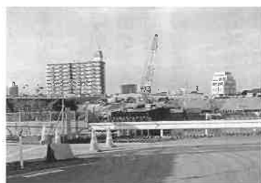
枇杷島橋 旧橋脚撤去作業
