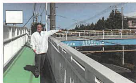
▲中原街道の歩道橋改修工事が完成
