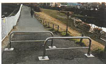
▲和泉川プロムナードの自転車止め改良工事完了
